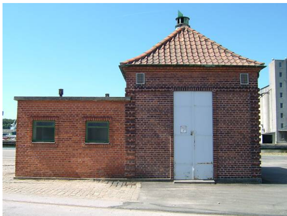
Østre Kaj 7-9 set fra Sverigesgade mod vest.
