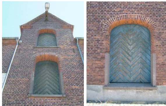
Døre og muredetaljer i Sverigesgade 6. Flot eksempel på muret stik (kurvehanksbue)
