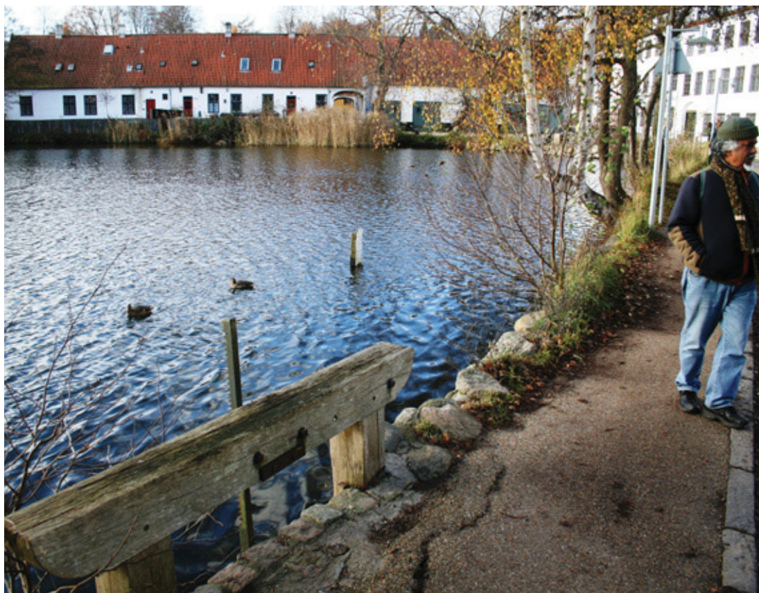
Mølledammen ved Brede Værk. I forgrunden stignbordet (frislusen) i vejdamningen. I baggrunden ses mesterlængen.
