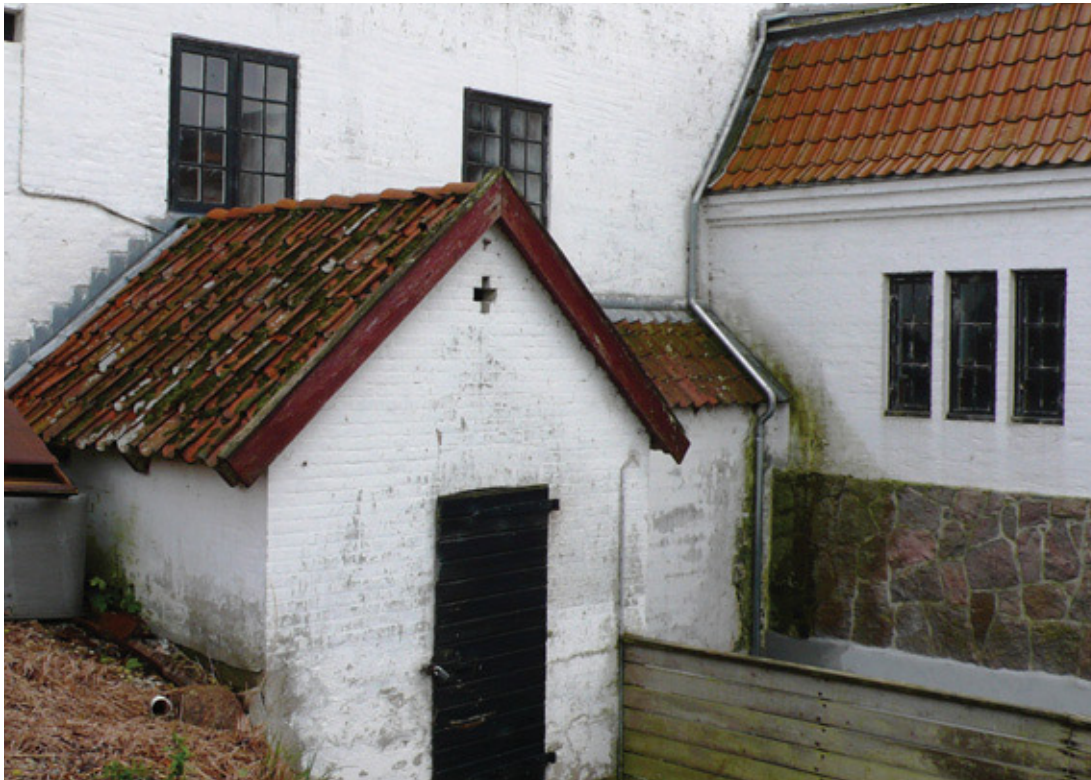
Ålekisten ved Esrum Mølle. Ålene fanges i et bassin inde i den lille hvide bygning.
