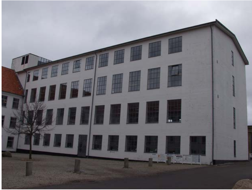
40 Overskæreri og tørrestue opført i 1809. Bygningen er fredet. (3)
