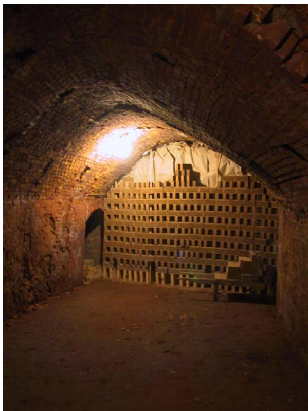
35 Brandkammer med rekonstruktion der viser hvordan stenene blev sat i ovnen.
