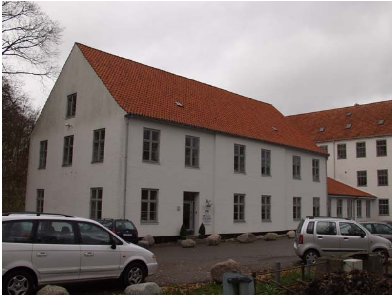
42 Bygningen forrest i billedet: Kontor og maskinstue opført i 1870. Bygningen er fredet. (26). Den mindre bygning i forlængelse af nr. 26: Valkeri opført i 1868. Bygningen er fredet. (24)
