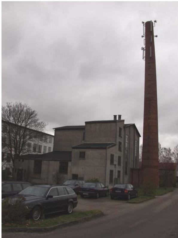
43 Kedel og maskinhus opført i 1936. Bygningen er ikke fredet. (8)
